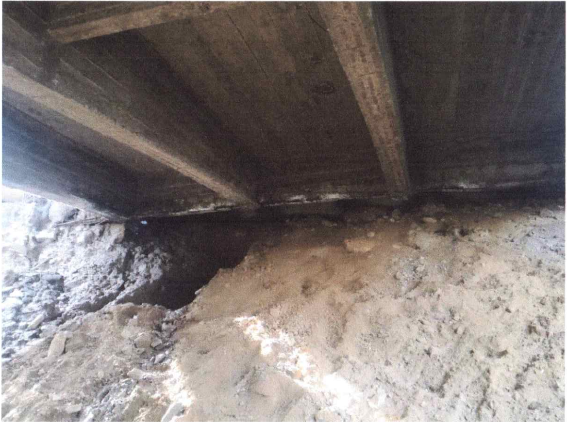
სურ. 8. მალის ნაშენის კონსოლის დაზიანებული ტორსი (ბოლნისის მხარე)
