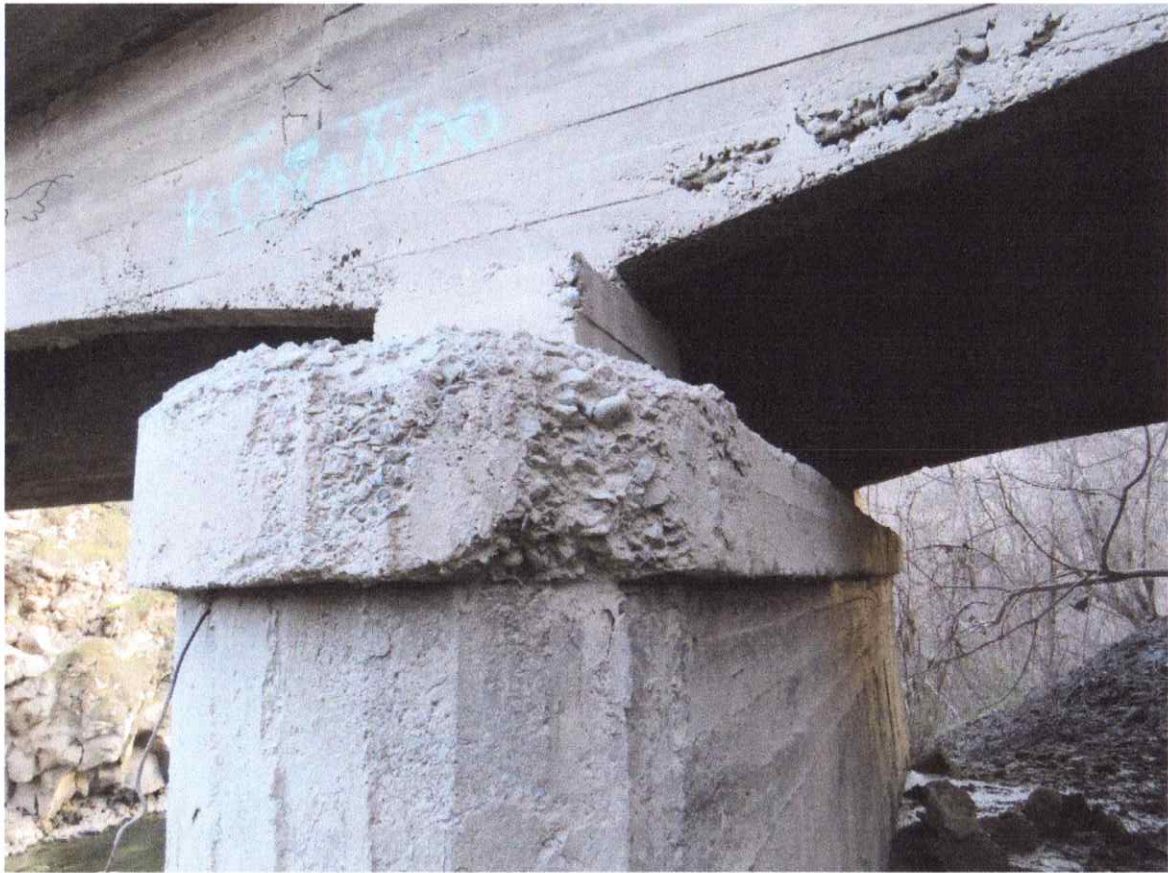
სურ. 10. №1 შუალედი ბურჯის ფერმისქვეშა ფილის დაზიანებული ბეტონი
