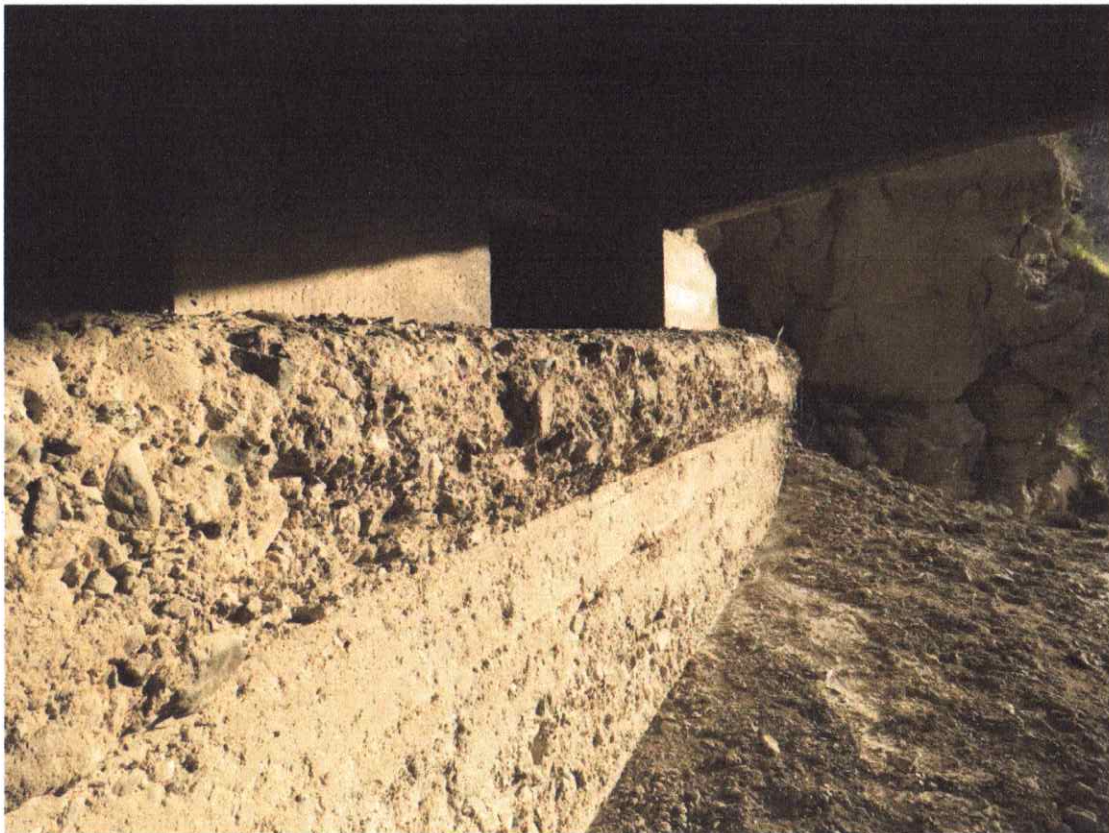
სურ. 11. №2 შუალედი ბურჯის ფერმისქვეშა ფილის დაზიანებული ბეტონი
