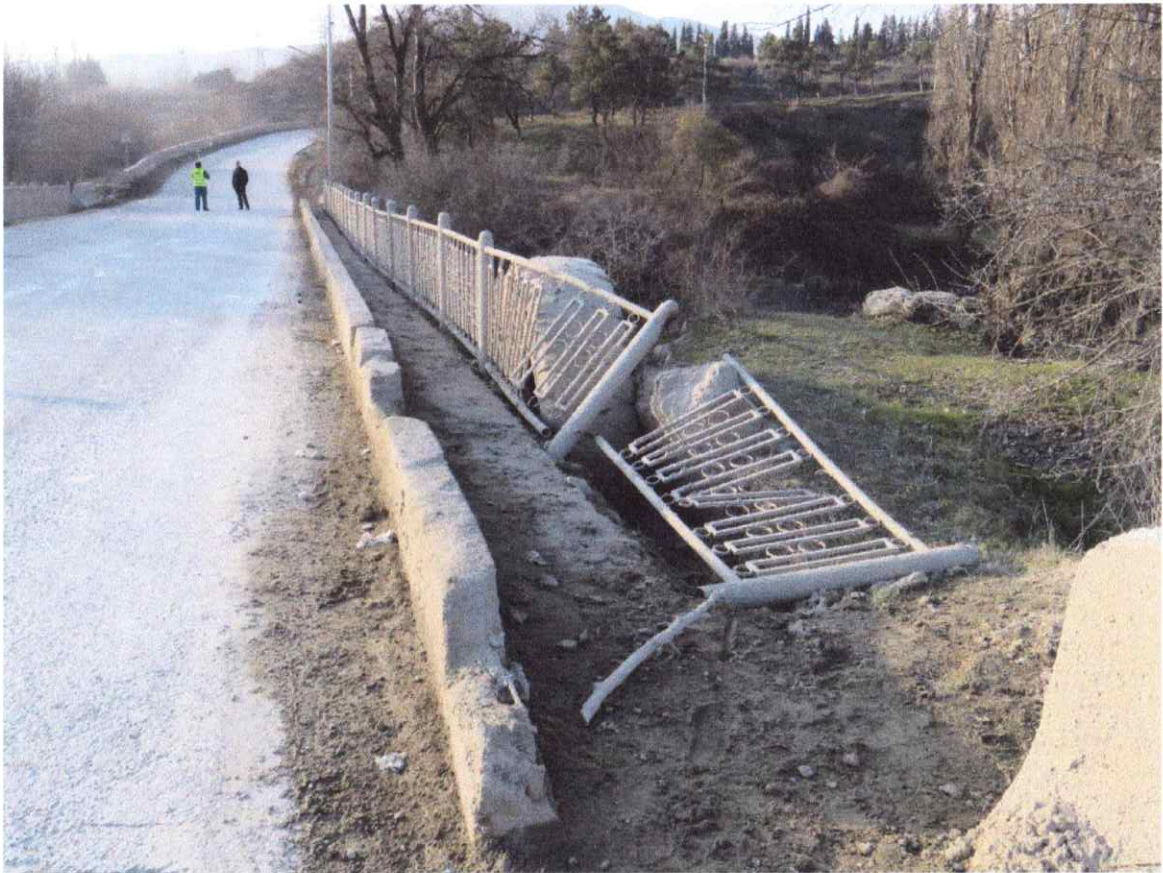
სურ. 2. დეფორმირებული ფოლადის მოაჯირის ფრაგმენტი
