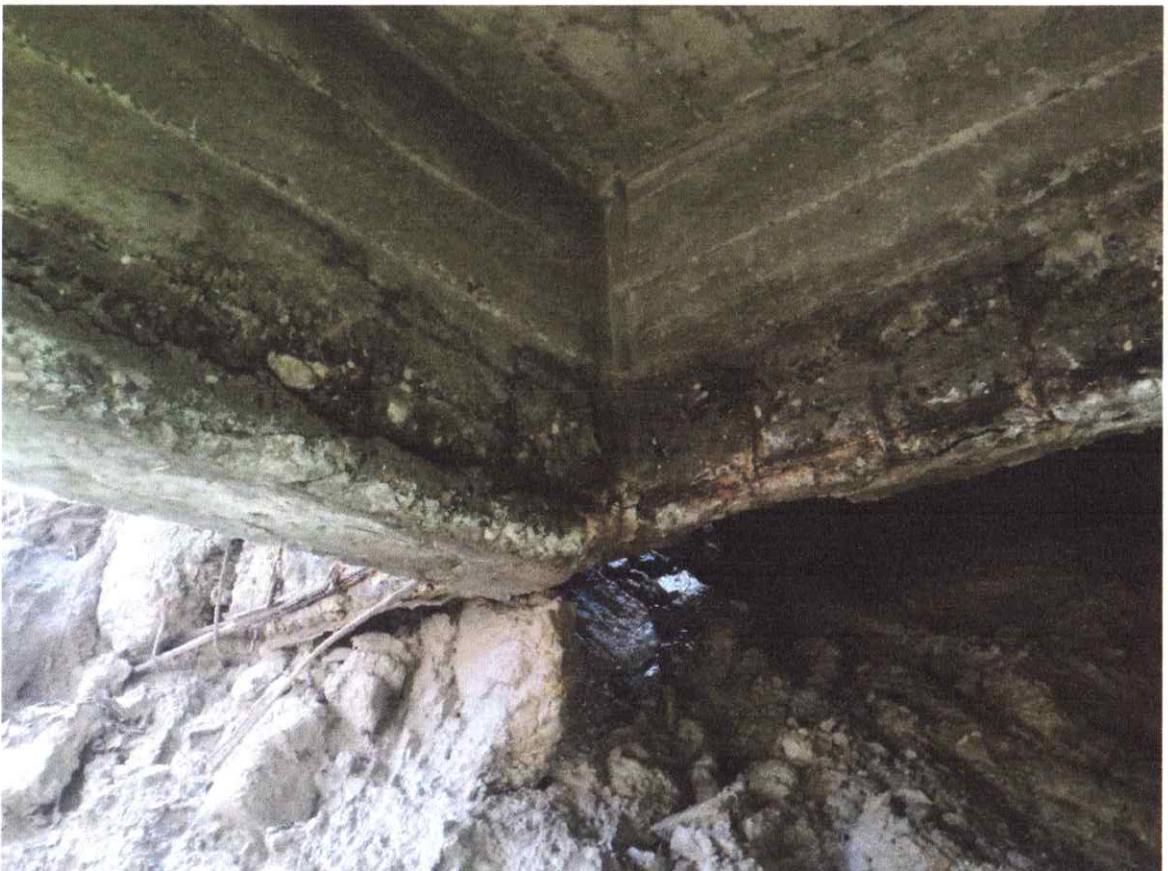
სურ. 9. ბეტონის დამცავი ფენის დაზიანება რკინაბეტონის კონსოლის ტორსზე
