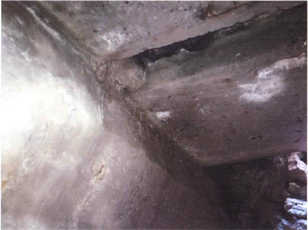
სურ. 12. დაზიანებული გადასასვლელი ფილები
