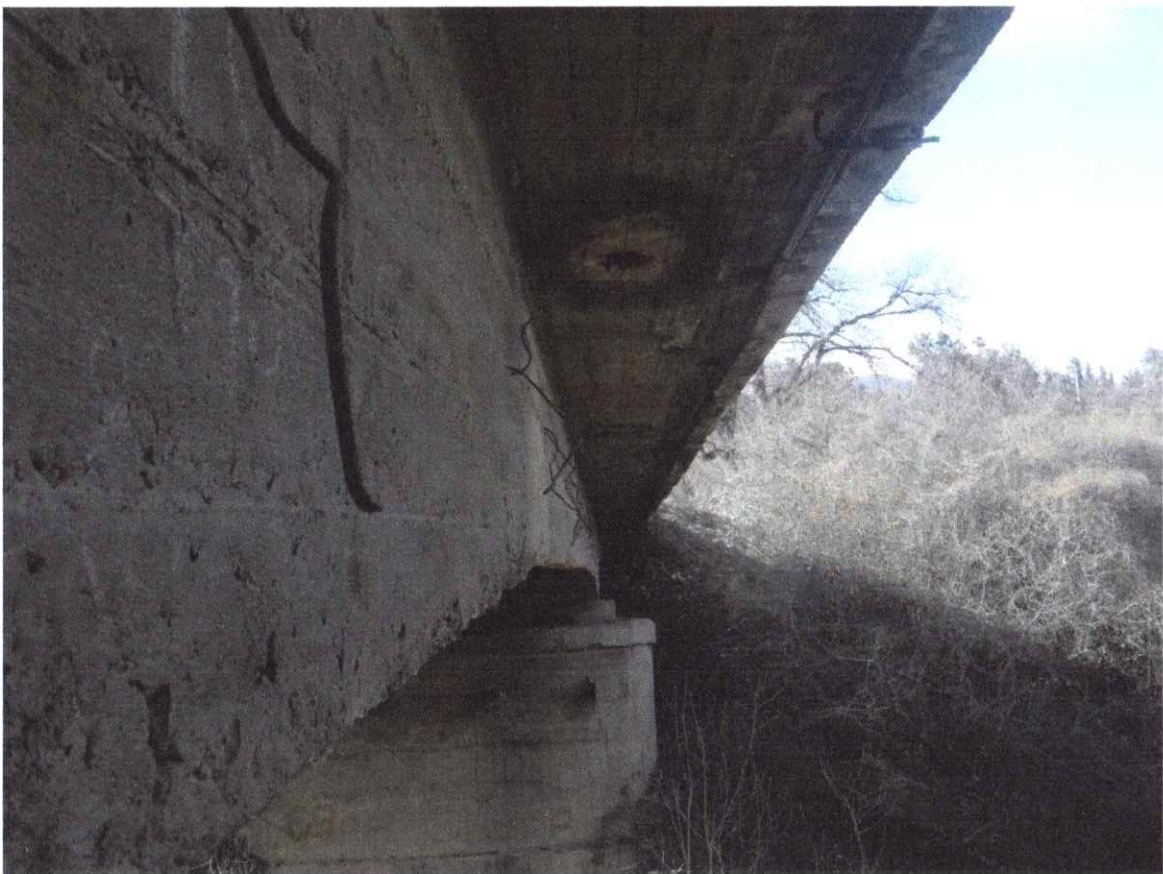
სურ. 3. დაზიანებებით სატროატუარე კონსოლის ქვედა მხარეს
