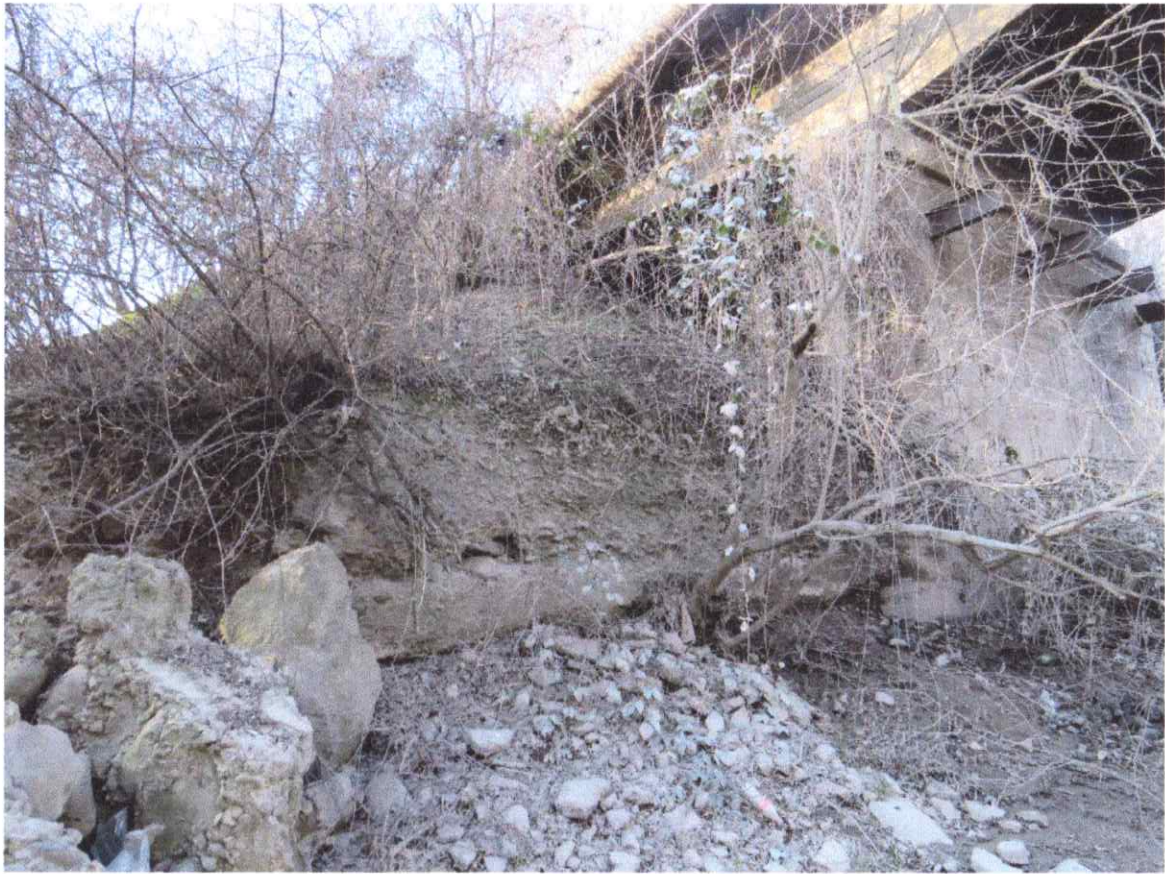
სურ.14. №1 შუალედი ბურჯის მიმდებარედ არსებული დაზიანებული საყრდენი კედელი
