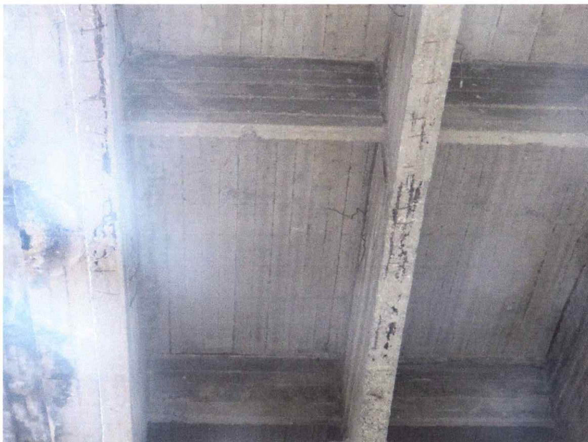
სურ. 4. მალის ნაშენის გრძივი წიბოების დაზიანებული დამცავი ფენის ბეტონი
