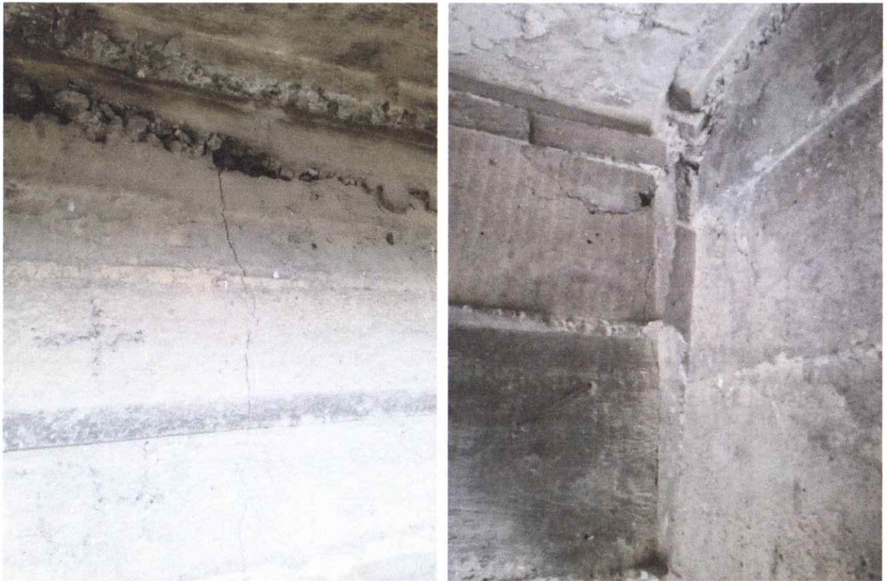
სურ. 6. დაზიანება (ბზარები) მაღის ნაშენის ქვედა მხრის გრძივ წიბოზე
